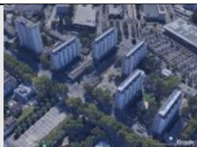
Vue d'ensemble des six Tours de Carouge googleearth
