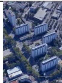
Vue d'ensemble des six Tours de Carouge googleearth
