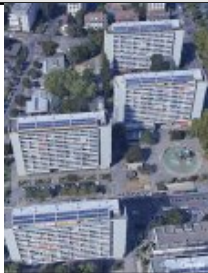
Panneaux solaires sur 4 des 5 Tours de Carouge A, B, D, E et F. googleearth
