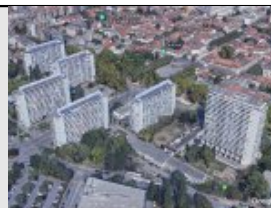
Vue d'ensemble des six Tours de Carouge googleearth
