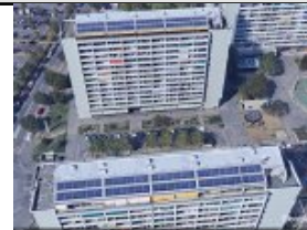
Panneaux solaires sur 2 des 5 Tours de Carouge A, B, D, E et F. googleearth
