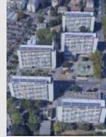
Panneaux solaires sur les 5 Tours de Carouge A, B, D, E et F. googleearth
